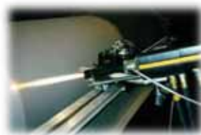
Metalización Thermal Spray
