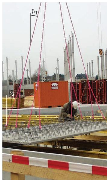
**Sistema "VIP-octopus" para prefabricados de hormigón**
