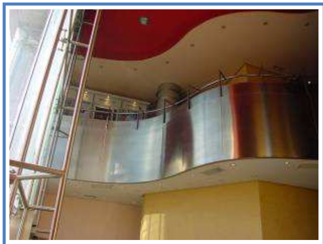
← Forrado de Paredes y Barandilla en Acero Inoxidable
