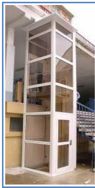
Cerramiento de un Ascensor con Carpintería de Aluminio
