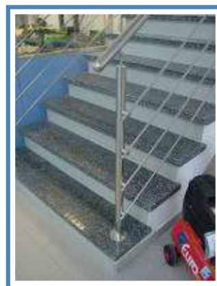
Detalles de Barandillas en Ac. Inoxidable
