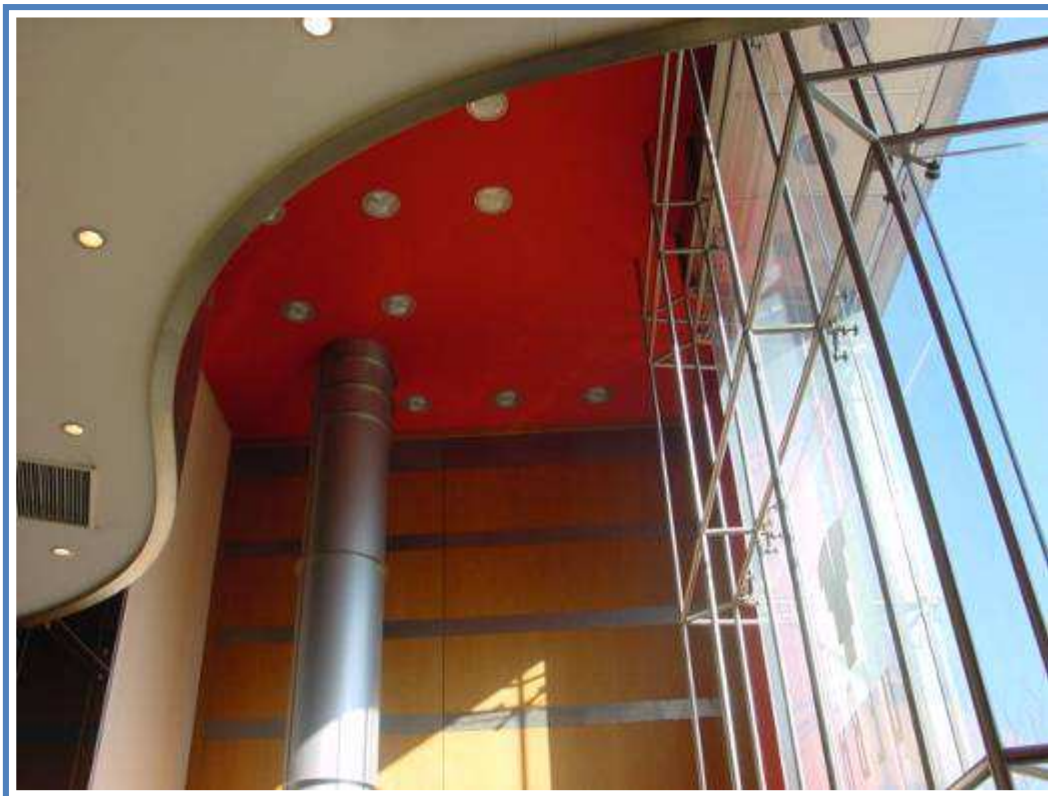
Interior de Fachada Muro Cortina
