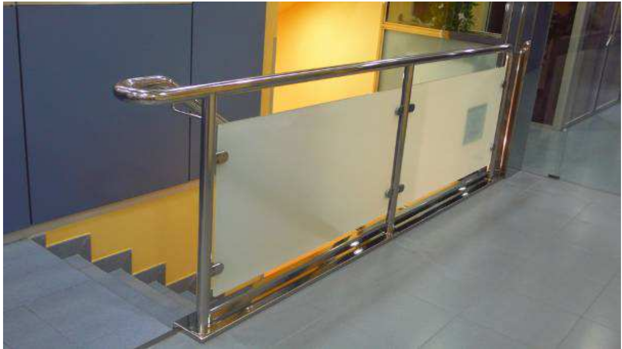
Barandilla de Ac. Inoxidable y Cristal. Detalle de Remates de la escalera en Ac. Inoxidable
