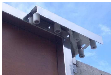
Detalles de las bisagras, el tope, la guía superior y el protector de las ruedas.
