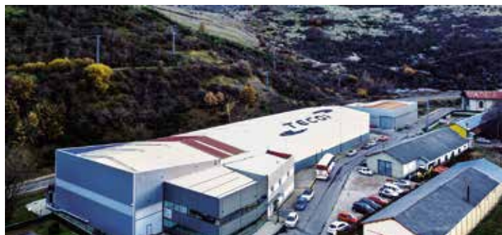
Nuevo Centro de Producción N4 7.000 m 2 - En construcción
