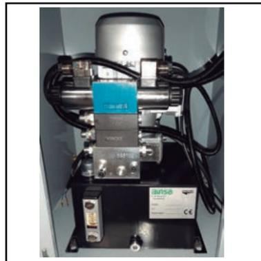
Grupo hidráulico en el interior del banco armario con visor de control.
