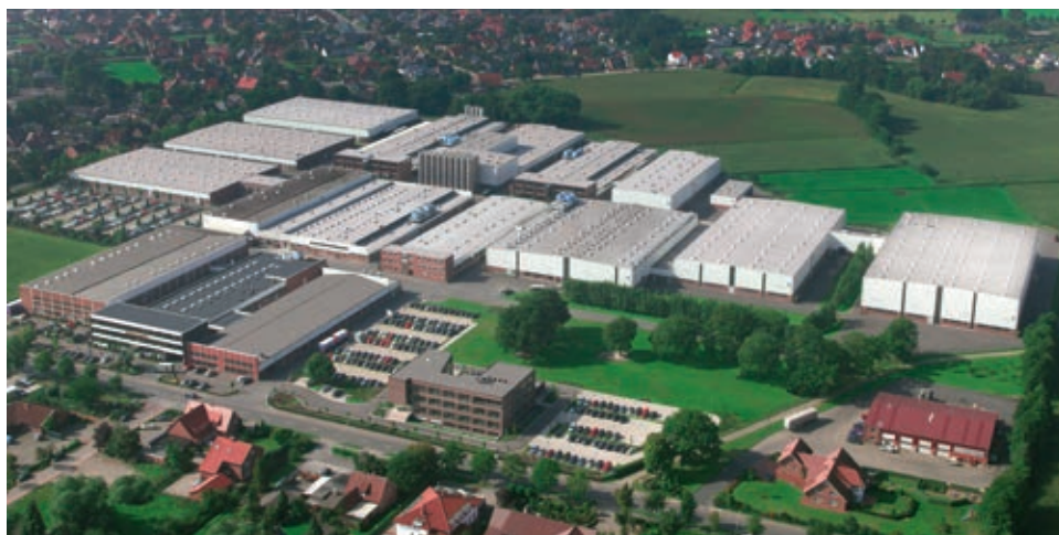
Alemania, Fábrica 1: Pöppelmann GmbH & Co. KG, Kunststoffwerk-Werkzeugbau, Lohne
