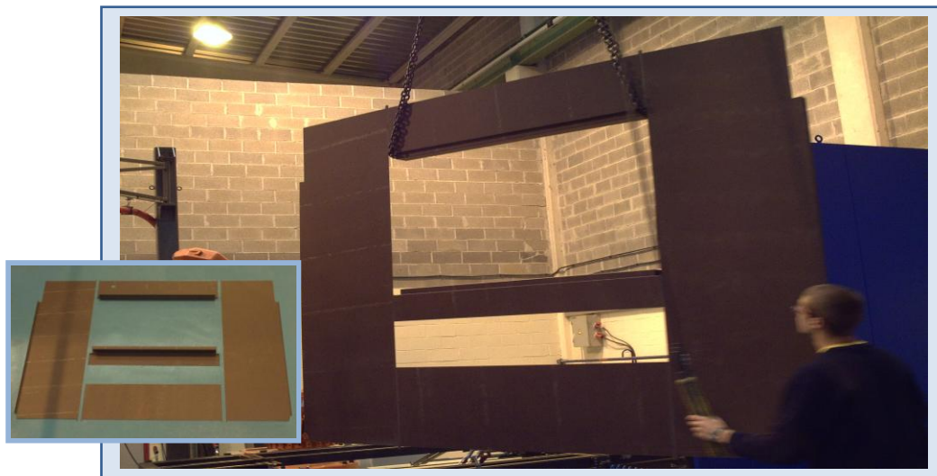
Conjunto (2900 x 2300 x 1,5 mm) de 5 chapas de acero corten soldadas a tope.
