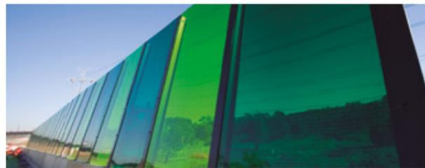
La Placa de Metacrilato de Extrusión es un termoplástico de excelentes propiedades técnicas que se obtiene a partir de granza de PMMA procesada con máquinas extrusoras, obteniendo placas de un calibre uniforme, bajo nivel de tensiones, excelente calidad óptica y una alta resistencia a la intemperie y al impacto.
