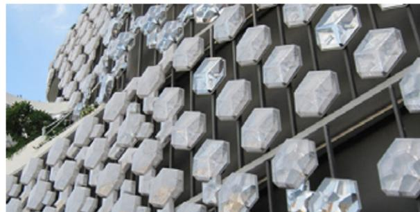
Placas de policarbonato transparentes con protección UV en las dos caras. Tienen una gran resistencia a la intemperie y a los impactos.
