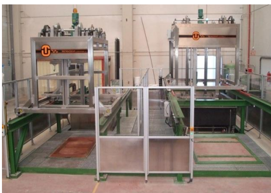
Descontaminación de PCBS
